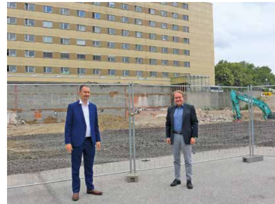
Für den Neubau der Bettenhäuser am Klinikum laufen bereits die Vorarbeiten. André Naumann, Interims-Geschäftsführer des Klinikums, und Helmut Radlmeier freuen sich darüber, dass nun auch die Förderung für das zweite Bettenhaus von der Bayerischen Staatsregierung bewilligt wurde.
